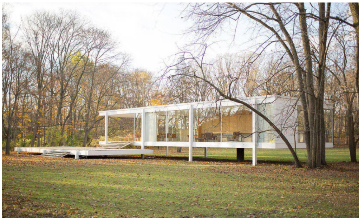
Ludwig Mies van der Rohe. Casa Farnsworth (1946-1951). Edifici situat a Plano (Illinois, Estats Units).
